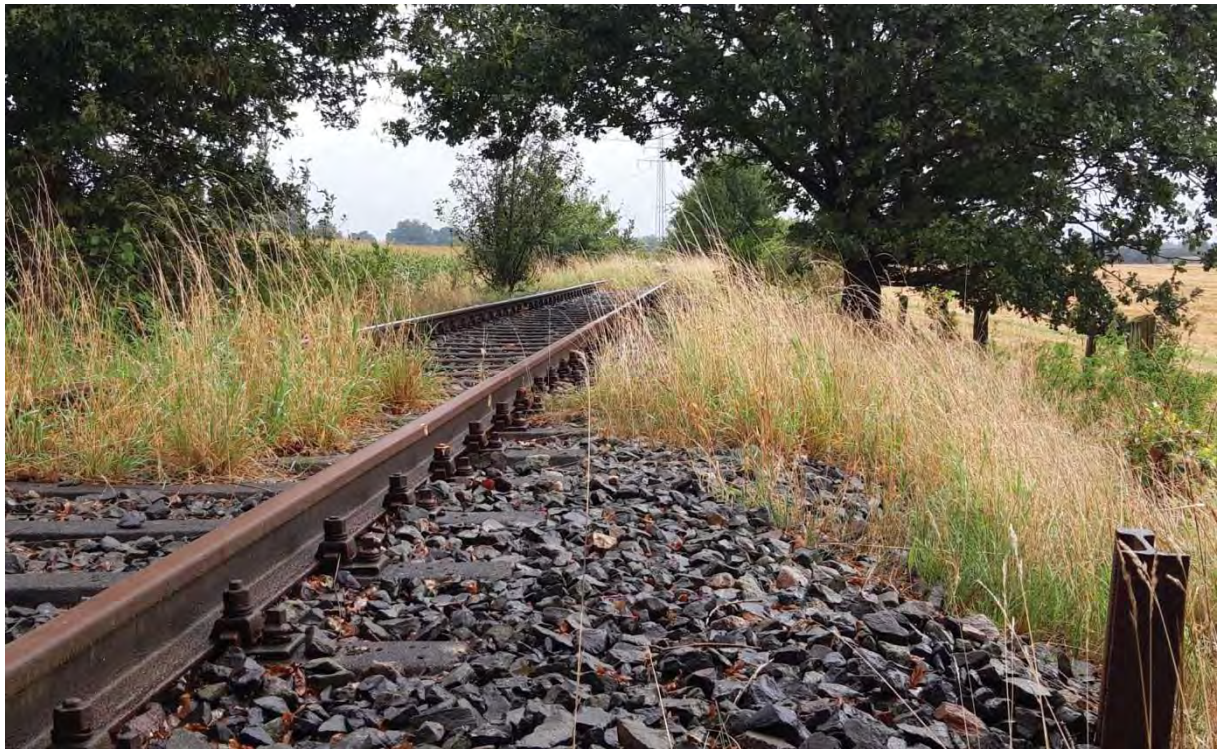
Abbildung 12: Ehemalige Bahntrasse (Blick nach Osten)
