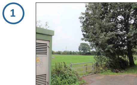
Solarpark nicht einsehbar
